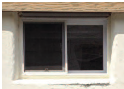
Después: Nueva Ventana corrediza Sótano
