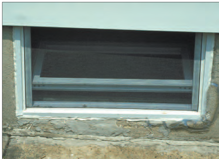
Después: Nuevo basculante Ventana de uPvc
