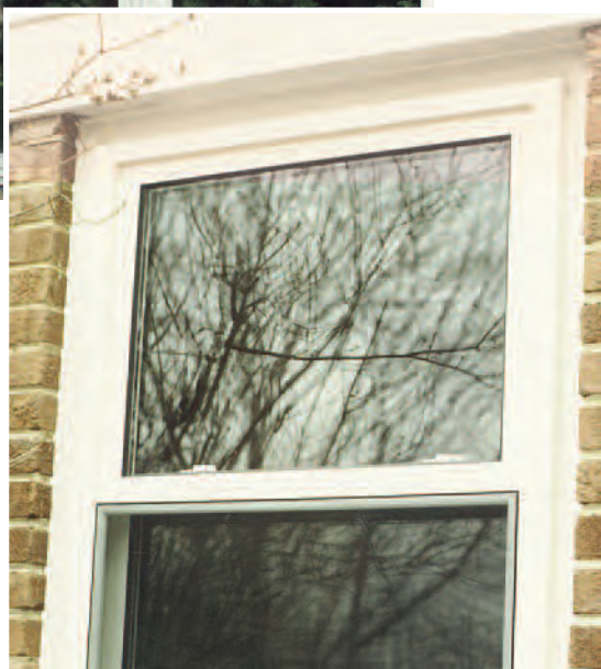
Nueva ventana de vinilo Revestimiento instalado con Jamba
